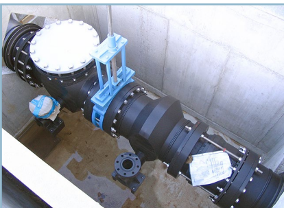
Schachteinbau, Projekt in Deutschland Valve chamber unit, project in Germany
