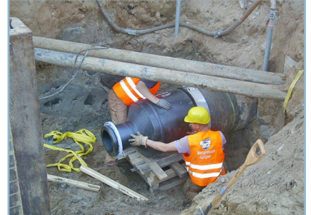
Reduzierung mit HP-Flansch Reducer with HP flange
